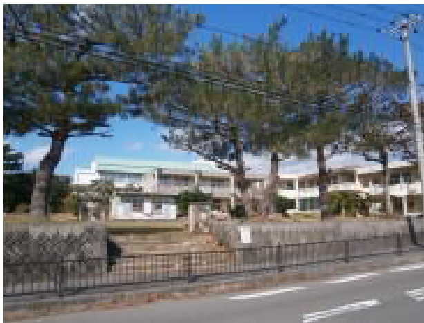
県道215号線から見た 正門
