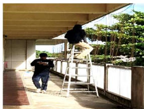
PTA 事業部：校舎修繕作業
